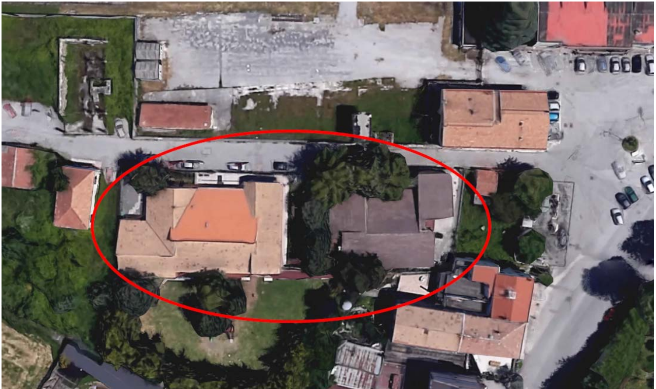
Fig. 2.13 – Complesso scolastico Tito Scalo: veduta aerea
